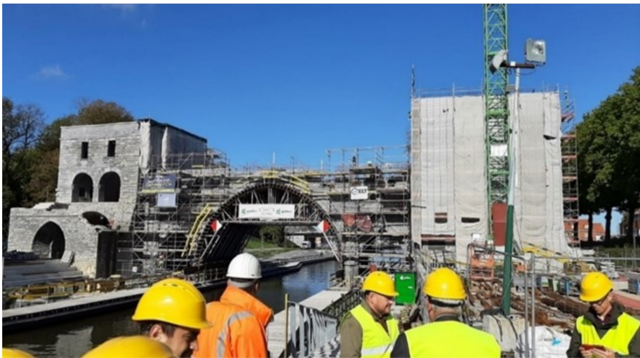
De herinrichting van de Pont des Trous combineerde hydrologische met historische en communicatieve uitdagingen.
